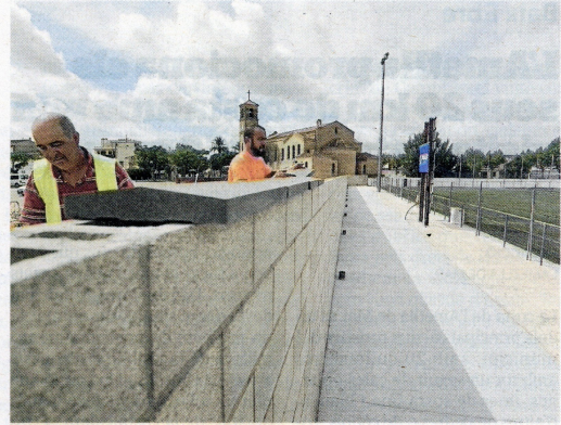
Operaris treballant a la zona. FOTO: JOAN REVILLAS
