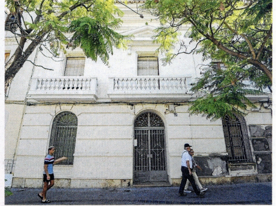
Aquest és l'edifici de l'antiga Duana. FOTO: JOAN REVILLAS
