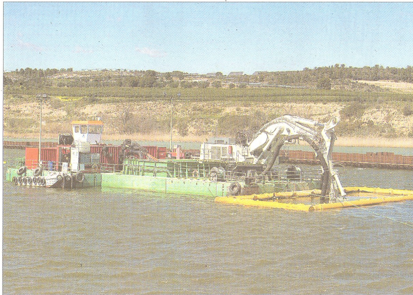
Imatge de la draga extractora dels llots tòxics acumulats a l'embassament de Flix. FOTO: JOAN REVILLAS
