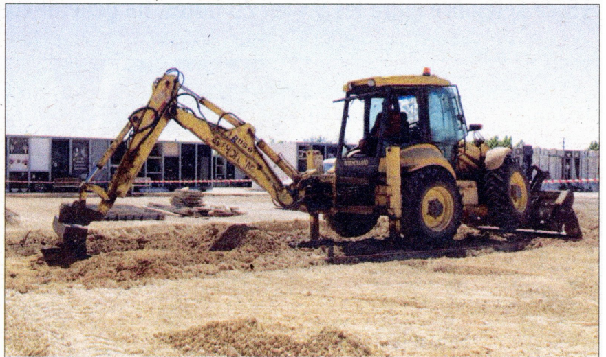
Imatge dels treballs d'ampliació del cementiri de Deltebre. / CEDIDA
