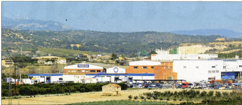
Imatge de les instal·lacions de Padesa a la capital del Montsià.
