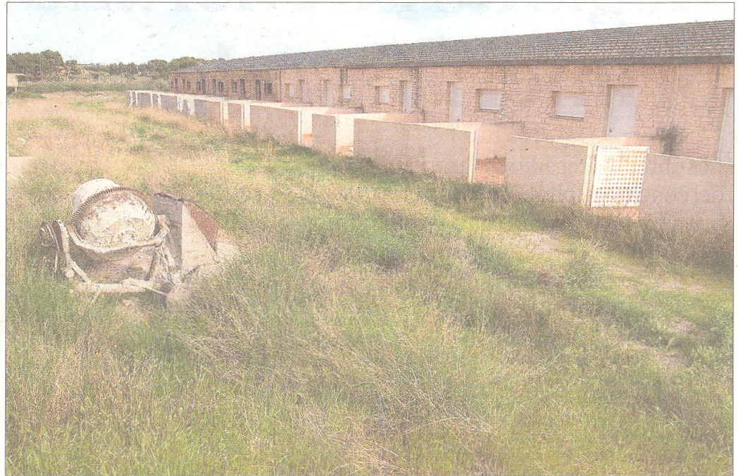
Complex de 13 habitatges per a temporers que s'enderrocarà a Masdenverge. FOTO: JOAN REVILLAS
