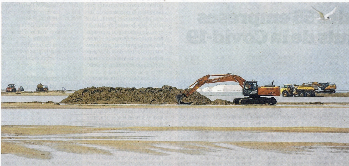
Imatge d'arxiu de treballs de recuperació de la barra del Trabucador. FOTO: JOAN REVILLAS
