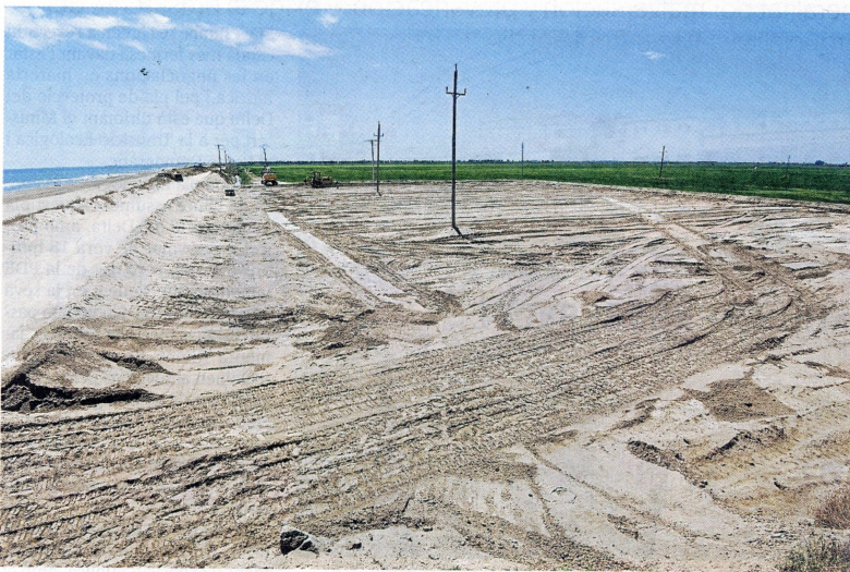
L'aparcament per a vehicles, en construcció a la zona de la Marquesa. FOTO: JOAN REVILLAS
