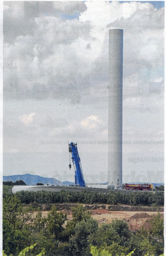
Parc eòlic en construcció a Vilalba dels Arcs, a la Terra Alta.
