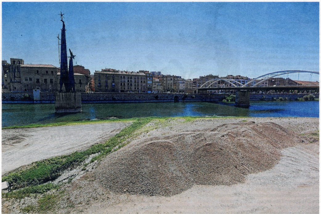
Treballs previs a la retirada, amb moviment de terres a la platja de Ferreries, aquesta setmana. FOTO: JOAN REVILLAS
