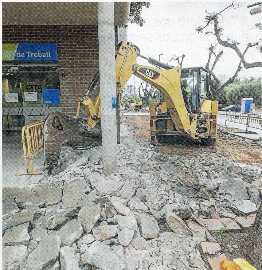
Màquines treballant sobre el terreny. FOTO: JOAN REVILLAS
