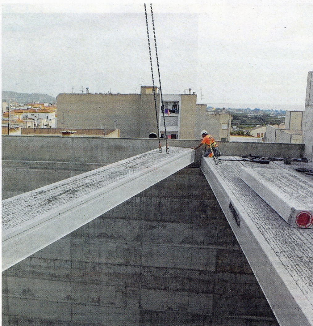
Treballs d'instal·lació de les grans bigues a la coberta de l'Auditori. FOTO: AJUNTAMENT ALCANAR/SISTEMA BINARI
