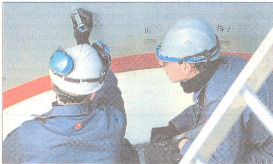
Dos operaris, ahir al migdia, treballant al fossat de transferència del recinte del magatzem nuclear individual d'Ascó. FOTO: JOAN REVILLAS
