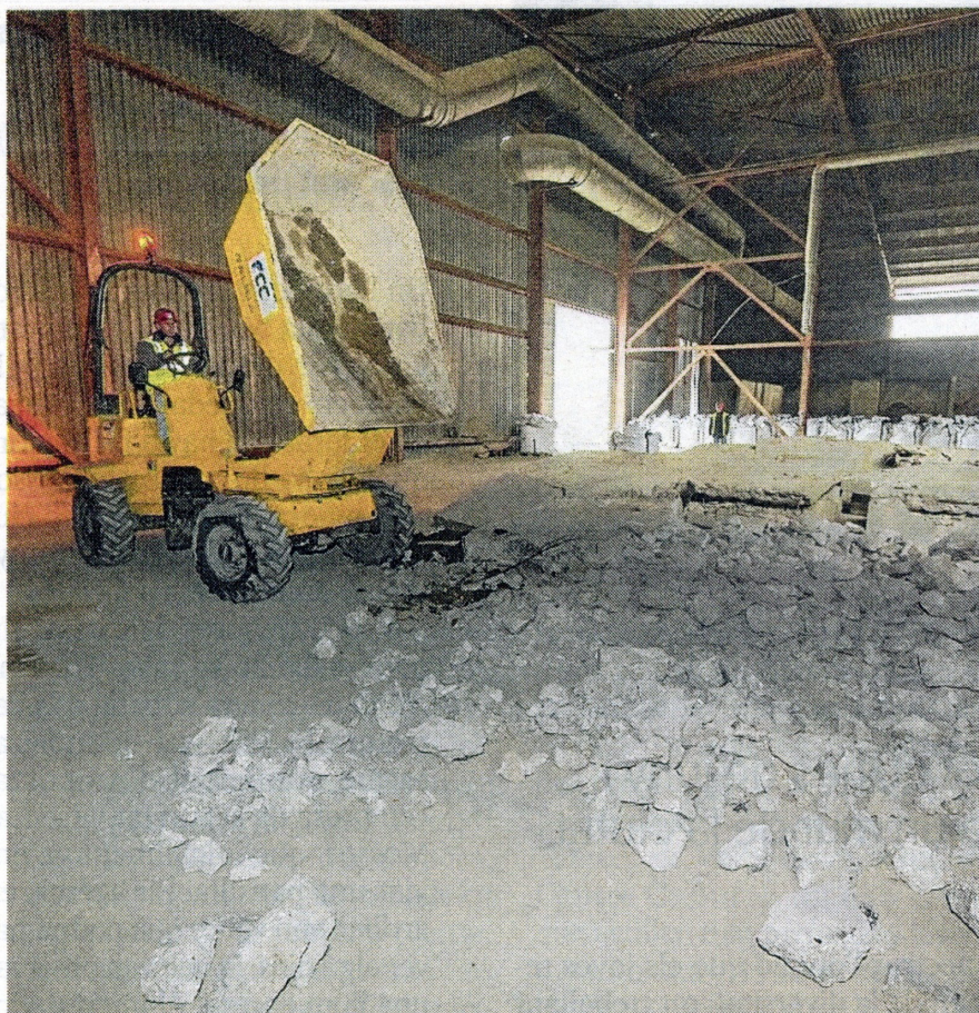
Desmantellament interior de la nau. FOTO: JOAN REVILLAS
