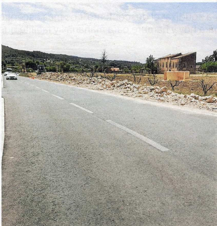
Imatge de l'enderroc, aquesta setmana. FOTO: DIPUTACIÓ DE TARRAGONA
