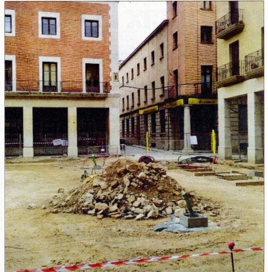
Aprofitant les obres de la plaça s'ha enderrocat el temple que coronava l'edifici de Correus que estava a punt de caure sol.
