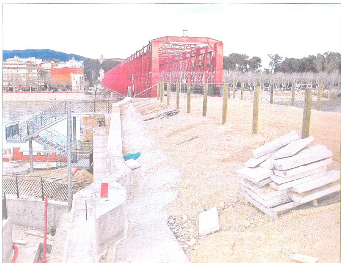
Un dels últims treballs està sent la instal·lació de les baranes al tram de via verda entre les antigues indústries Fabra i el pont del tren./ C.F.
