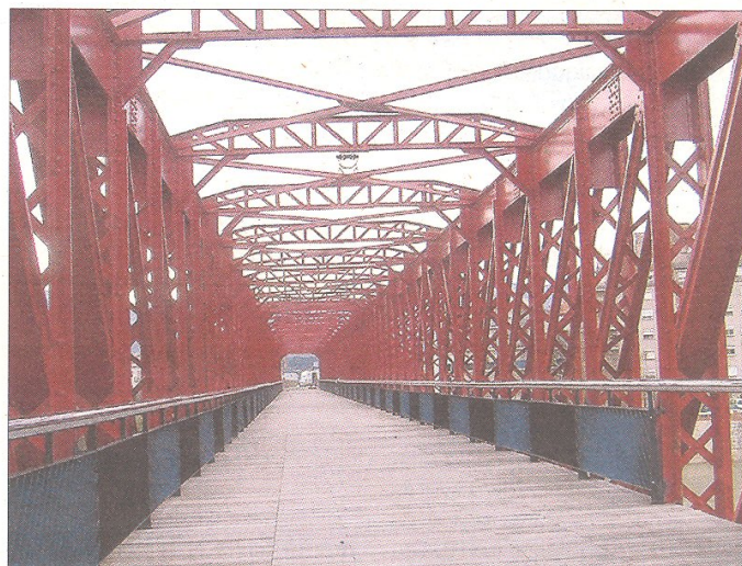
El pont del tren ja ha estat completament rehabilitat. / X.B.
