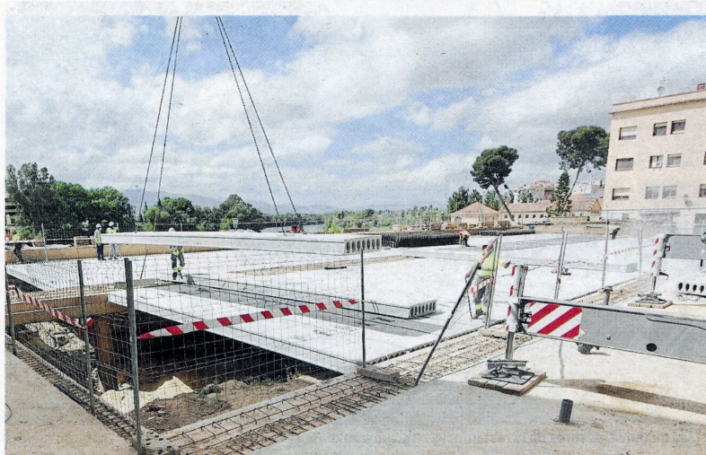
Operaris col·locant les bigues ahir a la tarda, a la plaça davant el temple. FOTO: JOAN REVILLAS
