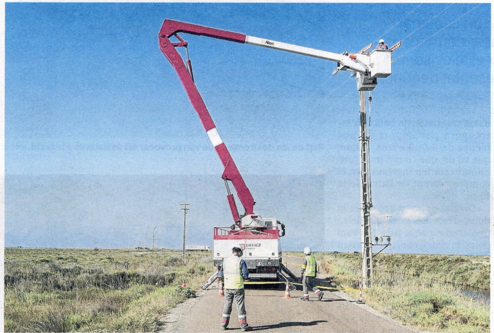
Operaris treballant en un pal elèctric al Delta. FOTO: JOAN REVILLAS
