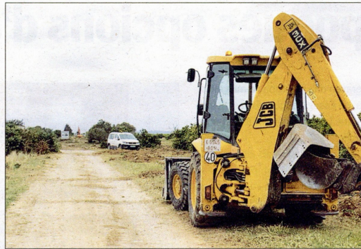
Obres a la carretera, en una imatge recent.
