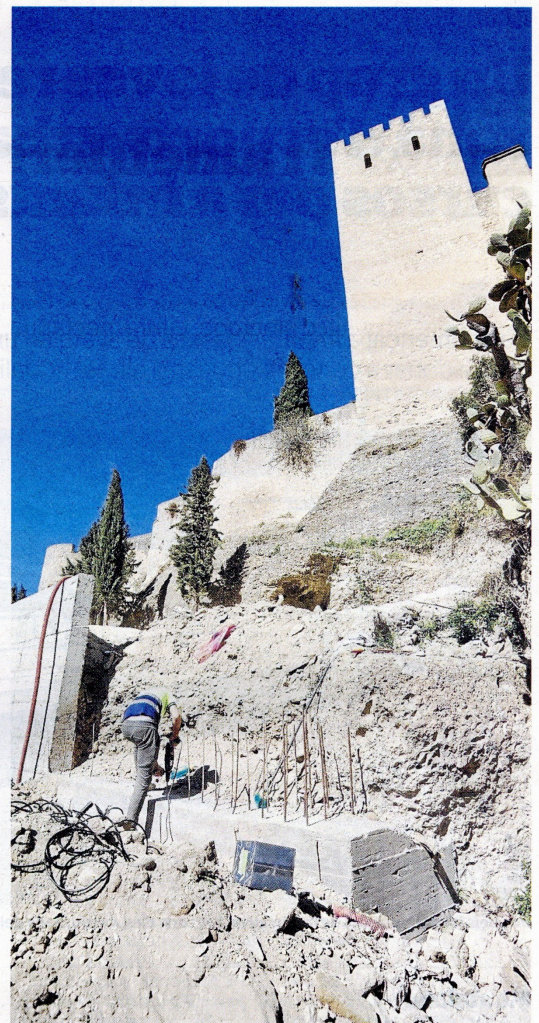
Operaris treballant en un dels murs de contenció, als peus del Castell de la Suda. FOTO: JOAN REVILLAS
