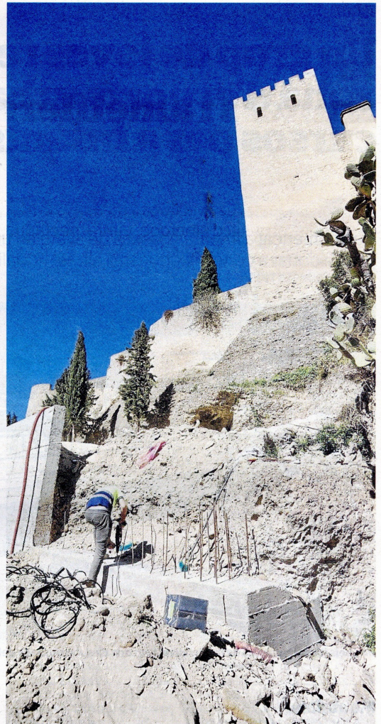
Operaris treballant en un dels murs de contenció, als peus del Castell de la Suda. FOTO: JOAN REVILLAS
