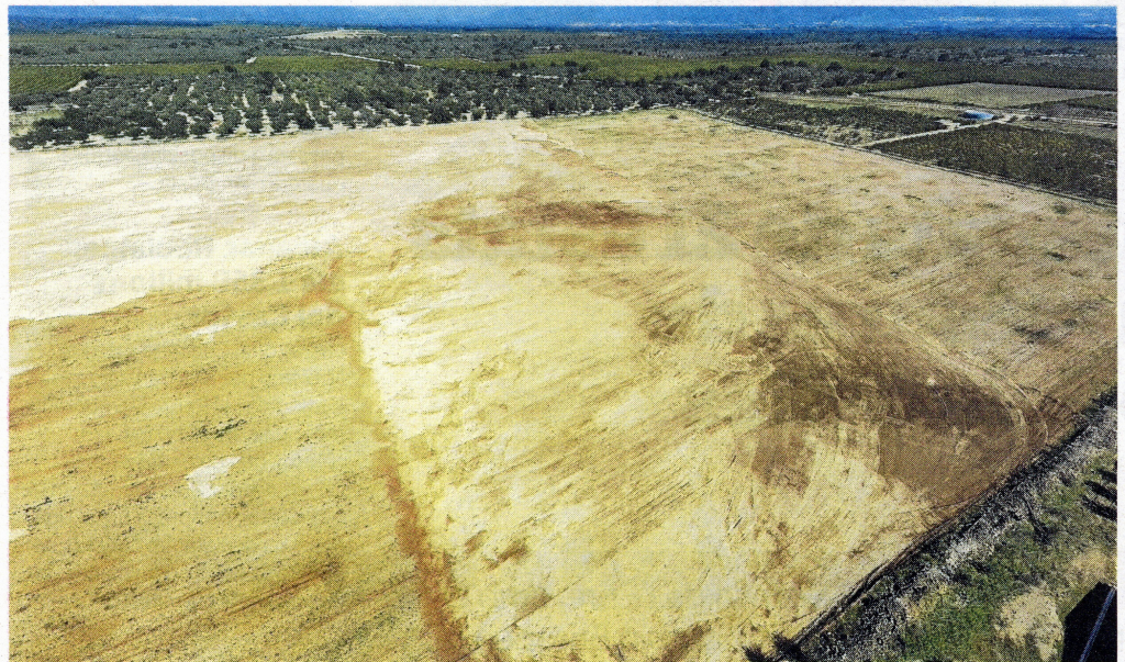
Els terrenys on s'ubicarà la planta de compostatge, a vista de dron. FOTO: JOAN REVILLAS
