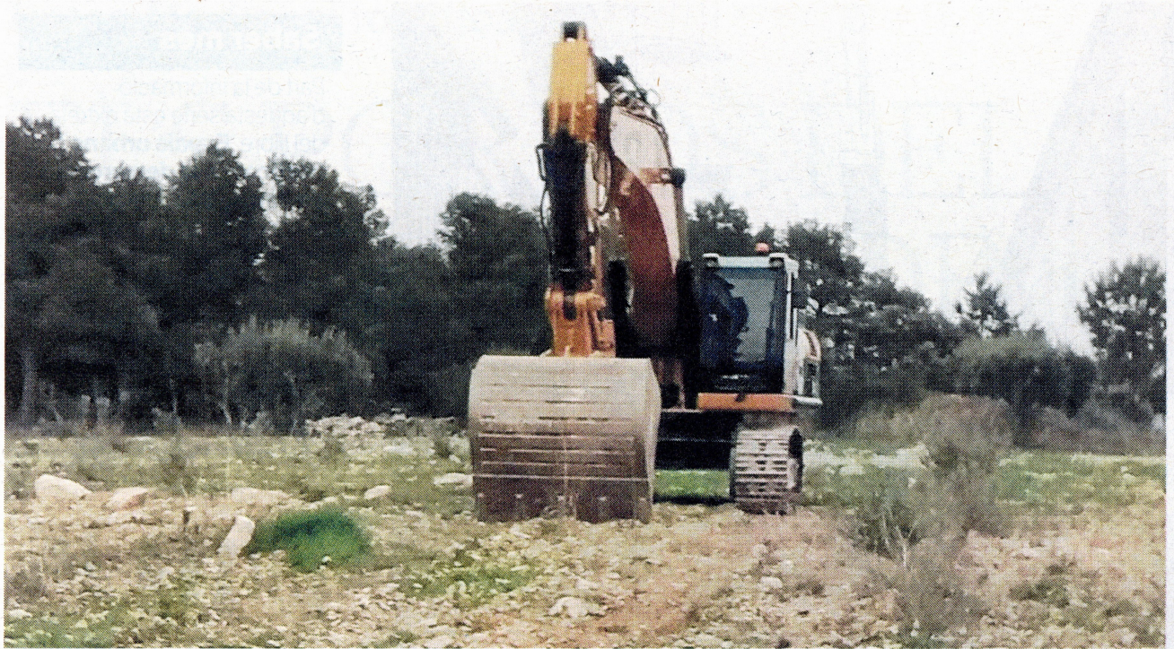
Màquines treballant ja sobre el terreny a Vilalba dels Arcs. FOTO: ACN
