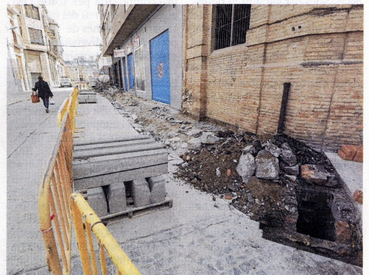
Adequació de les voreres al carrer Alfara de Carles. FOTO: JOAN REVILLAS
