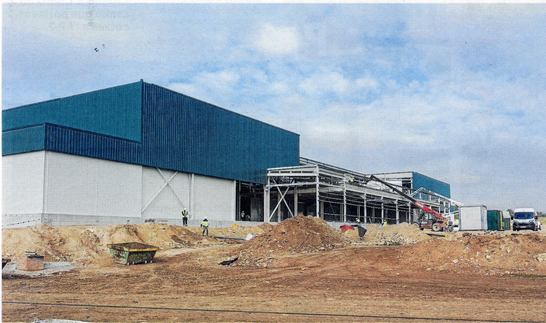
Les obres de la planta de producció de Florette al polígon Catalunya Sud. FOTO: JOAN REVILLAS
