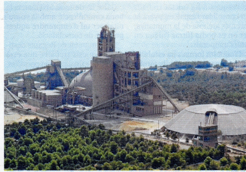
La fàbrica de Cemex a la costa d'Alcanar. FOTO: JOAN REVILLAS
