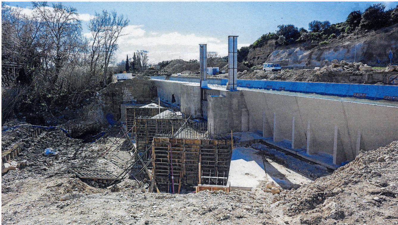
Imatge de les obres, que continuen a l'altura del barranc de Sant Antoni. FOTO: JOAN REVILLAS
