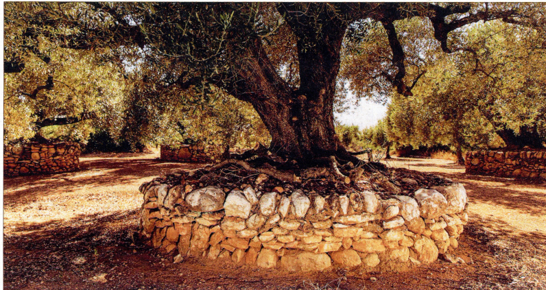
Imatge d'un exemplar de valona, la construcció de pedra seca que protegeix les oliveres. / TAULA DEL SÉNIA
