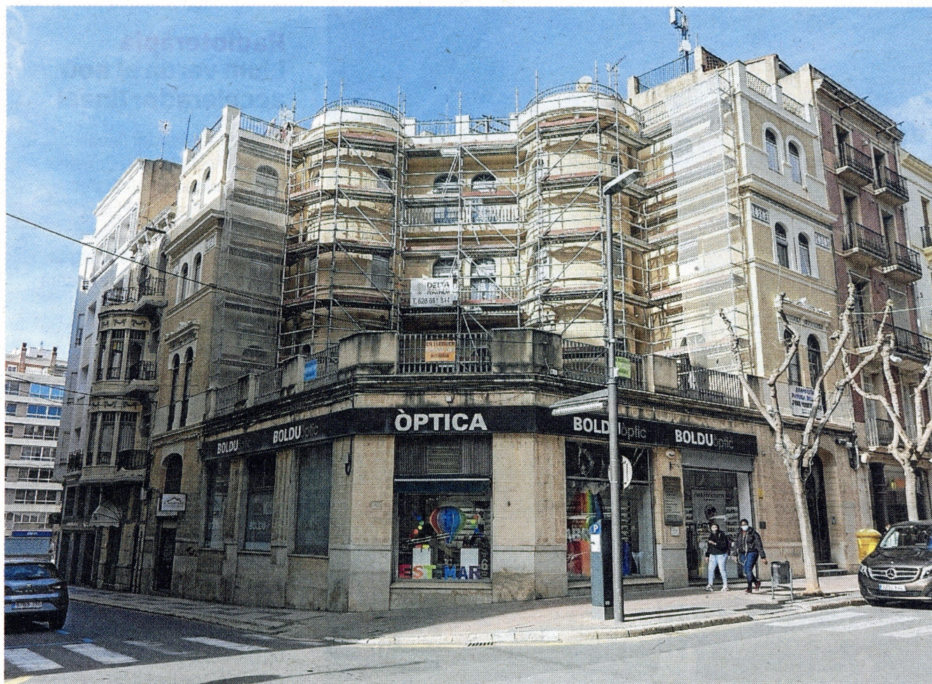
Edifici al carrer Cervantes, en obres. FOTO: JOAN REVILLAS
