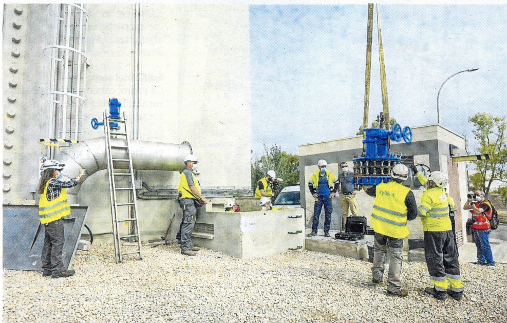
Treballs de revisió de les canonades del CAT. FOTO: JOAN REVILLAS
