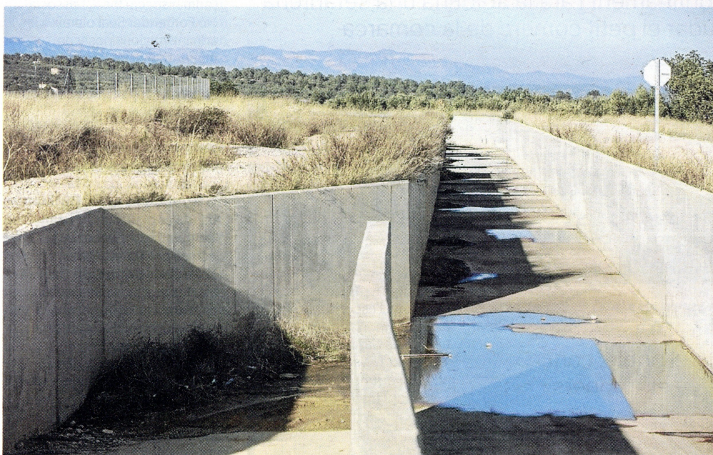
El canal de formigó del regadiu Xerta-Sénia, actualment buit. FOTO: JOAN REVILLAS
