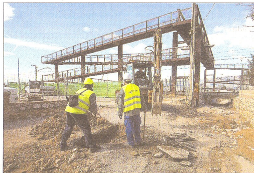
Imatge de l'inici dels treballs de millora de la capacitat de desguàs del barranc de la Llet, ahir al matí. FOTO: JOAN REVILLAS
