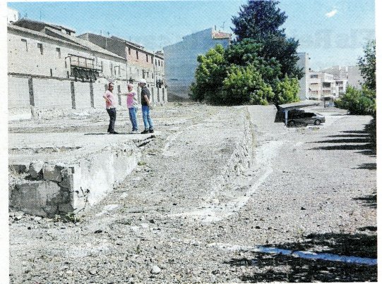
L'espai on s'habilitarà l'aparcament. FOTO: ENDESA
