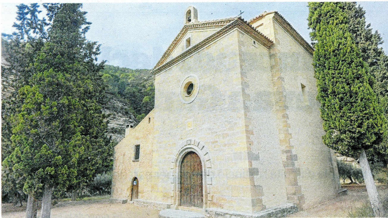
l'ermita de Sant Francisco, després de la segona fase de les obres. FOTO: JOAN REVILLAS
