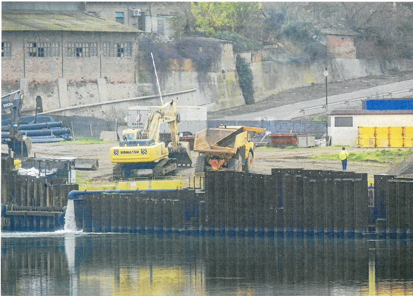
Treballs actuals i bombeig de l'aigua, a l'embassament de Flix. FOTO: JOAN REVILLAS
