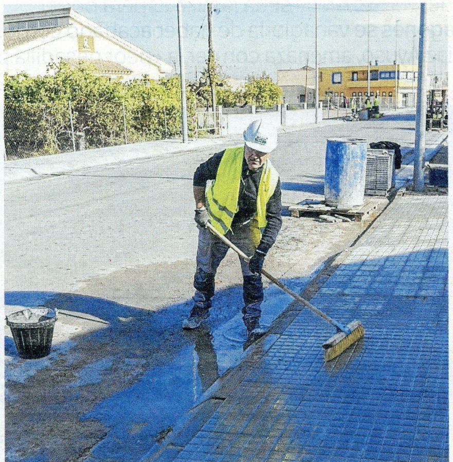
Obres en marxa de millora de les voreres. FOTO: JOAN REVILLAS
