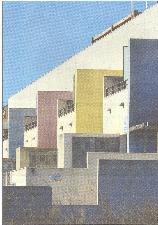
Aquests són els habitatges amenaçats d'enderroc per no complir la normativa. La majoria són segones residències. FOTO: JOAN REVILLAS
