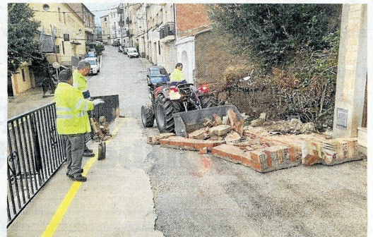
També Paülès es va aixecar ahir amb tots els carrers plens de fang, camins afectats i dos murs caiguts. FOTO: CEDIDA
