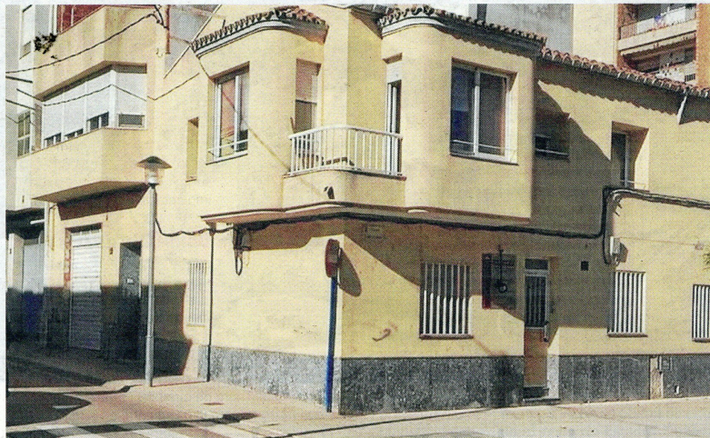
L'illa de cases afectada per la construcció del futur pàrquing de l'Hospital. FOTO: AJUNTAMENT D'AMPOSTA
