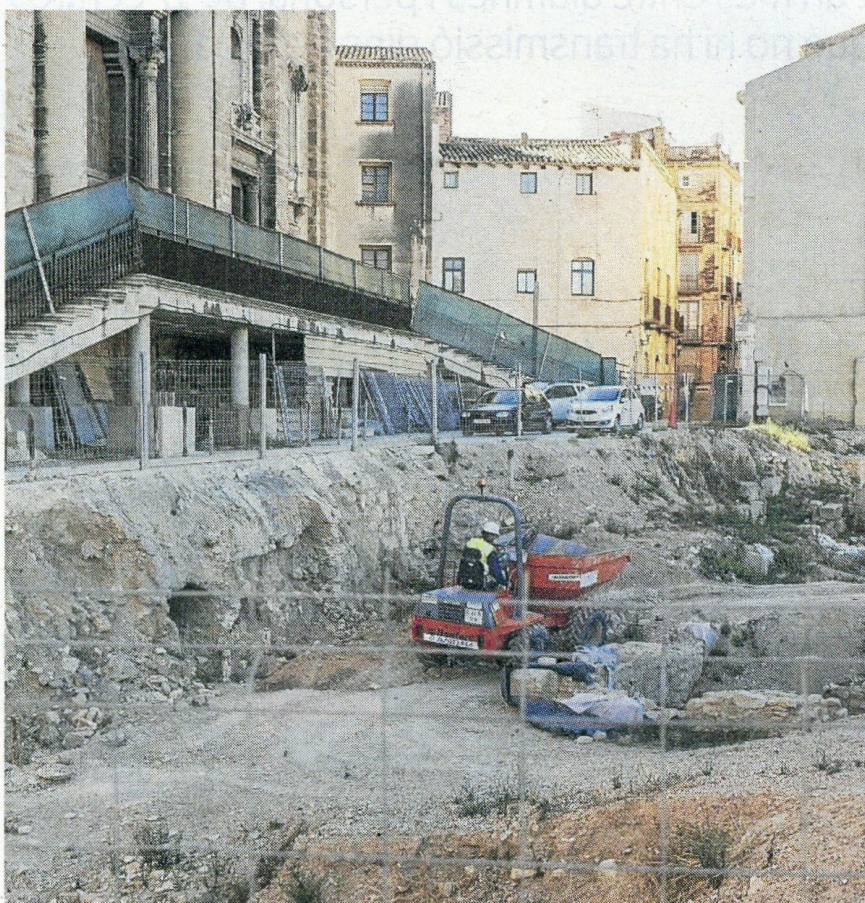
Obres en marxa a la plaça. FOTO: JOAN REVILLAS
