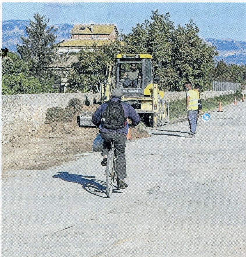
Les obres ja estan en marxa. FOTO: JOAN REVILLAS
