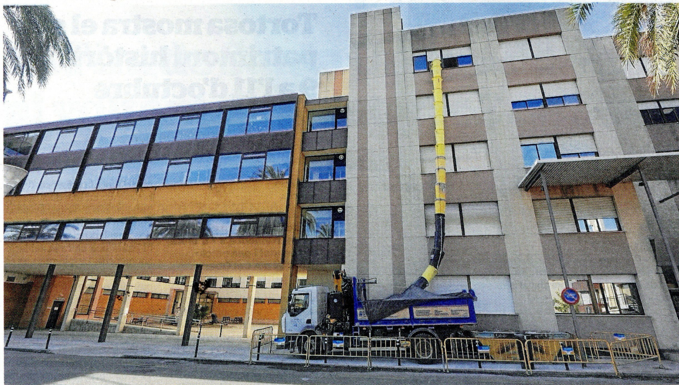
Obres a l'Hospital de la Santa Creu de Jesús, ahir al matí. FOTO: JOAN REVILLAS
