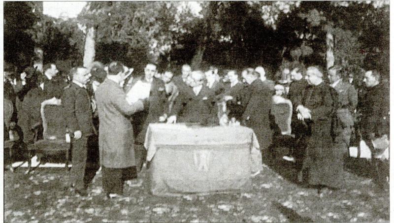
L'estació Oliverera de Tortosa estava pensada com el gran centre de recerca sobre l'olivera i la seva producció. Malauradament la guerra va fer que el projecte no tires endavant. A la foto el solemne acte de col·locació de la primera pedra vora a la part de darrere del Parc. FOTO ARXIU
