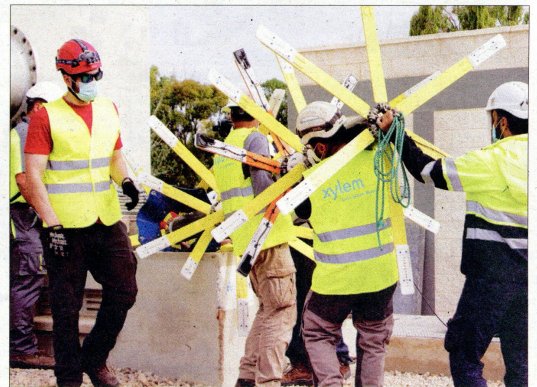
A l'esquerra, imatge de la canonada del CAT que va rebentar el passat 3 de gener a l'Ampolla. A la dreta, el torpede Pipe Diver que s'ha inserit per a inspeccionar l'estat de la xarxa principal del CAT des de Campredó fins a Constantí. / CEDIDA I NÚRIA CARO
