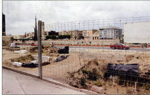
Imatge de les obres aturades de la plaça. / N. CARO
