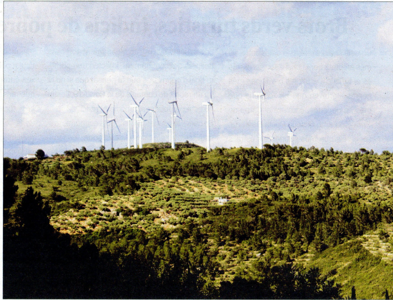
Un conjunt d'aerogeneradors vistos des de l'ermita del Coll de l'Alba. FOTO NÚRIA CARO
