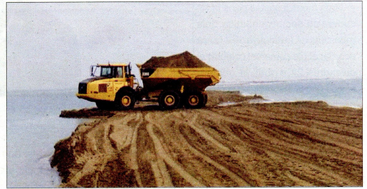
Imatge de les obres del camí que l'empresa Infosa realitza a la barra del Trabucador. / EBREDIGITAL
