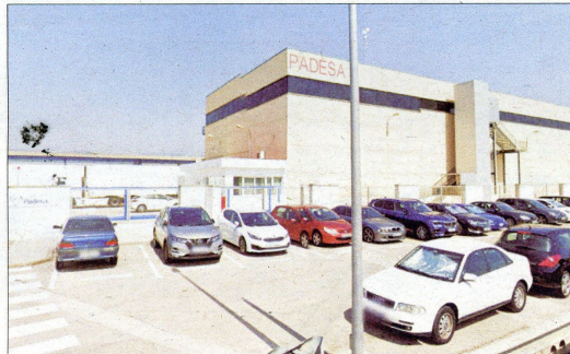
Una imatge de la planta de Padesa al terme de Roquetes.
