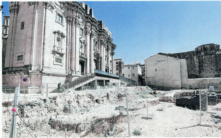
Estat actual de l'espai on s'ha de construir la plaça, davant la catedral. FOTO: JOAN REVILLAS
