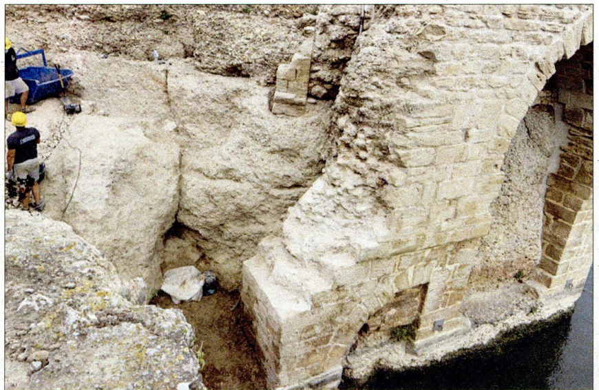
Imatge de les excavacions a la zona del castell d'Amposta. / ACN
